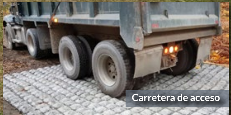
Relleno de grava para camino residencial
