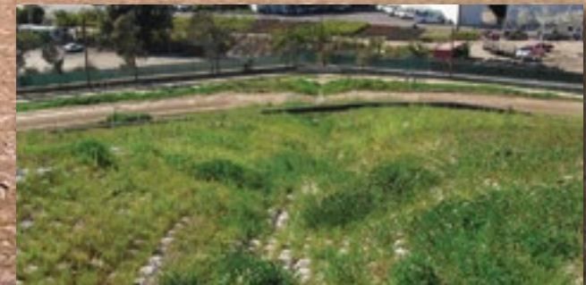
bajante de 60' de ancho 4 años después de la instalación
