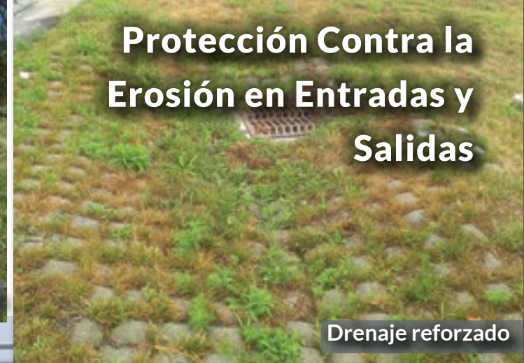
Salida reforzada con Flexamat®, 3 años después
